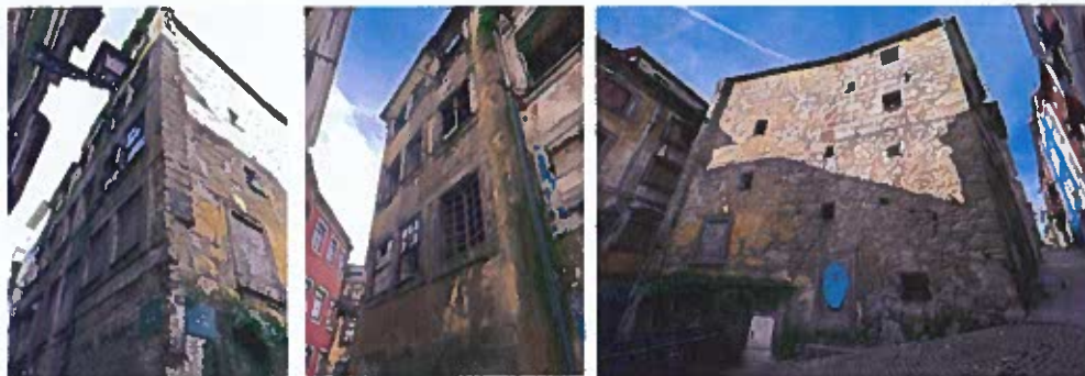
Figura 26: Fotografias da situação existente do prédio sito na Rua do Souto, nºs 2 a 8 e Rua dos Pelames, nºs 3 a 7
