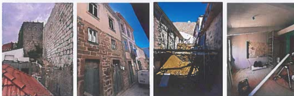
Figura 28: Fotografias da obra da Rua Francisco da Rocha Soares, nº 36 a 48
