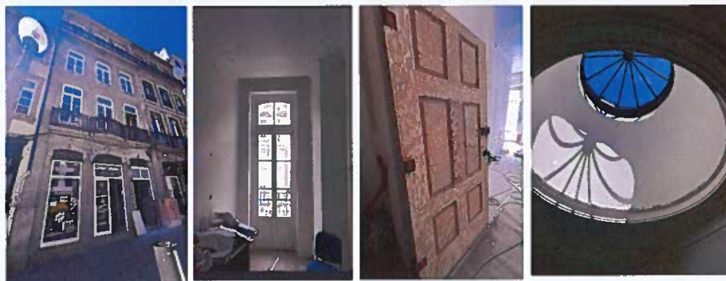
Figura 29: Fotografias da obra da Rua Mouzinho da silveira, n.º 133 a 137
