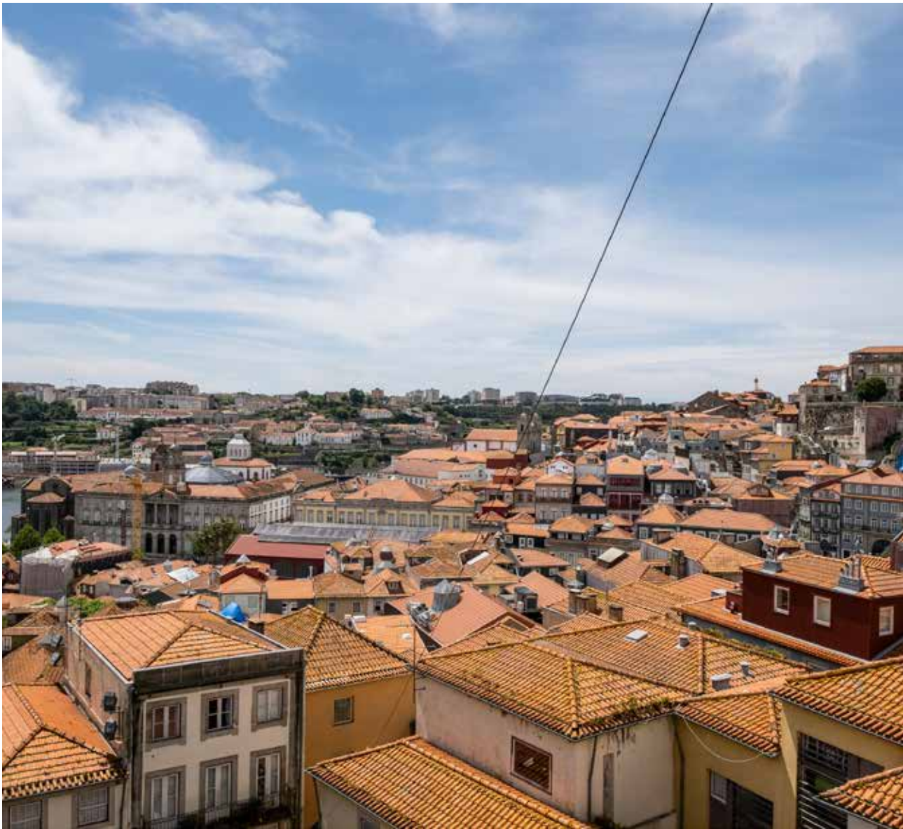
Fig 9 Vista sobre as coberturas do CHP. Fonte: Fotografia de Filipa Brito (2021)
