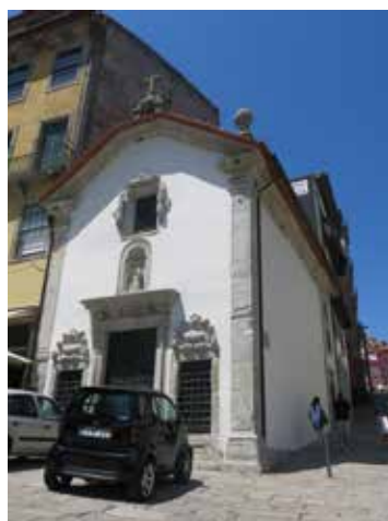
Fig. 20 Capela da Senhora do Ó Fonte: Porto Vivo, SRU (2020) Chapel of Senhora do Ó Source: Porto Vivo, SRU (2020)
