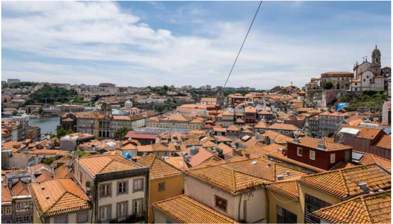
Fig. 16 Vista sobre as coberturas do CHP. Fonte: Fotografia de Filipa Brito (2021)
