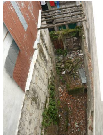
Estrutura vertical e horizontal - parcela 07
