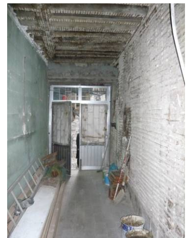
Parede interior em tabique - parcela 06
