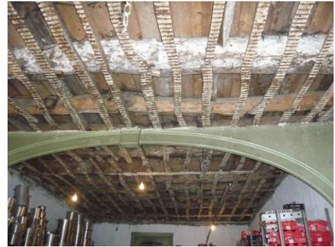
Estrutura horizontal no primeiro andar da parcela 09
