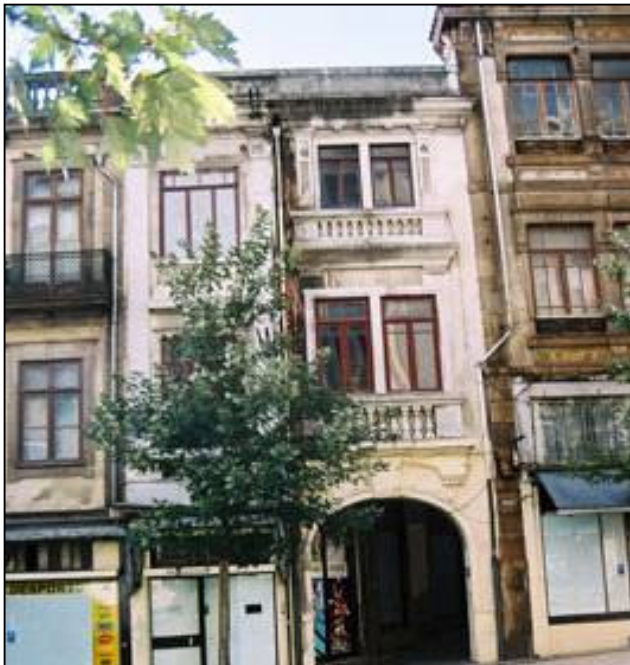
Frente para a R. Sá da Bandeira e entrada da Travessa da Formosa
