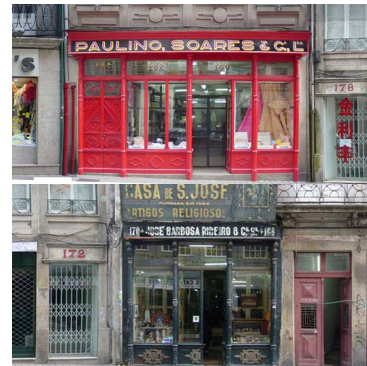
Fotografia das fachadas em ferro Parcelas 22 e 23- R. das Flores
