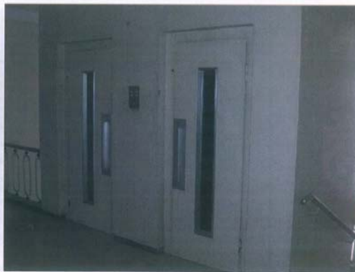
Fig.10 – Acessos verticais de distribuição a partir da entrada da Avenida dos Aliados
