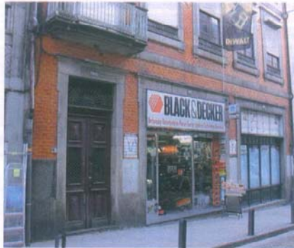
Fig. 1 – Fachada principal do imóvel - R/ch
