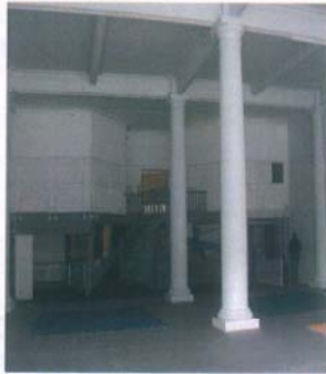
Fig. 11 – Rés-do-chão e construção aligeirada
