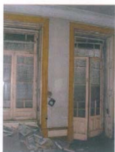
Fig. 15 – Caixilharia danificada
