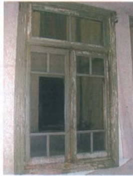
Fig.13 – Caixilharia em madeira
