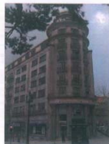
Fig. 4 – Fachada de gaveto
