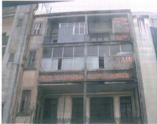
Fig. 5 – Perspectiva do imóvel – fachada de tardoz
