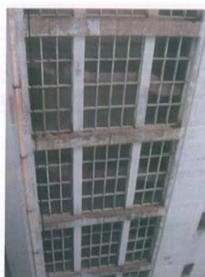
Fig. 6 – Fachada de tardez – caixilharia fixa
