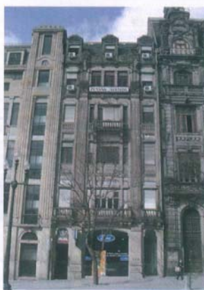
Fig. 1 – Perspectiva do imóvel – Av. Dos Aliados
