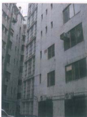
Fig. 5 – Fachada de tardez
