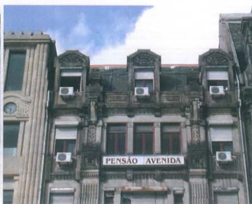
Fig. 2 – Perspectiva do imóvel – Av. Dos Aliados
