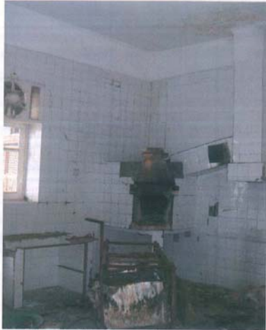
Fig. 19- Cozinha de apoio
