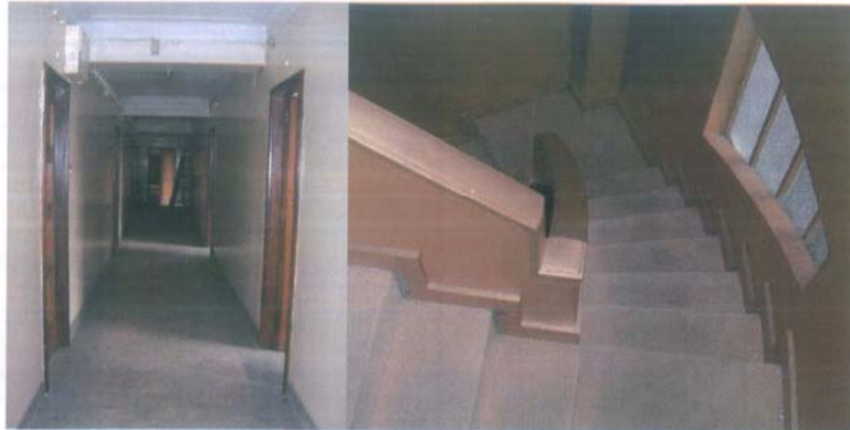
Fig. 11 – Perspectiva do interior – Corredor de distribuição
