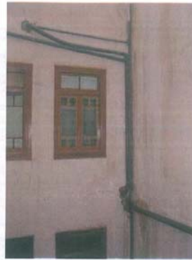
Fig. 8- Perspectiva do saguão – rede de águas residuais
