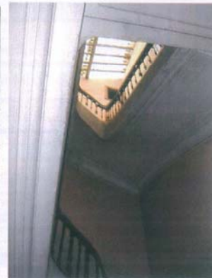
Fig. 10 – Caixa de escadas
