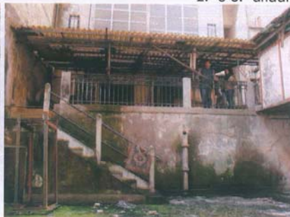
Fig. 4 – Logradouro do imóvel. Com ligação ao logradouro da parcela 002
