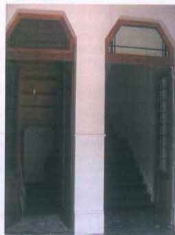
Fig. 7 – Acessos para cave e pisos superiores a partir do nº. 179
