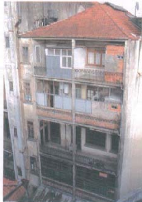
Fig. 3 – Perspectiva do imóvel – fachada de tardoz
