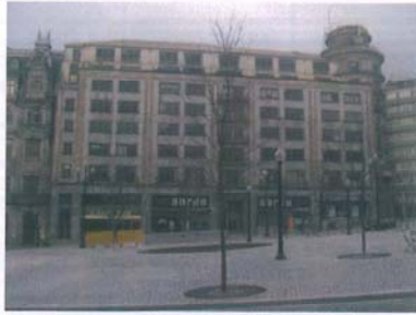
Fig. 1 – Perspectiva do imóvel – Av. Dos Aliados
