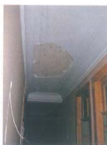
Fig. 16 – Tecto de fasquio, danificado
