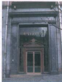
Fig. 3 – Entrada - Av. Dos Aliados
