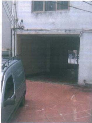
Fig. 22 – Entrada lugares de estacionamento
