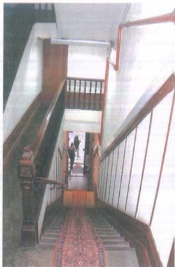
Fig. 9– Perspectiva da caixa de escadas
