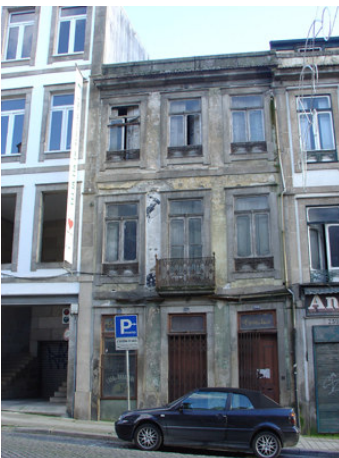
Fotografia 1 – Vista do alçado principal
