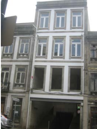
Fotografia 1 – Vista do alçado principal
