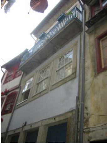
Fotografias 1 e 2 – Vistas do alçado principal
