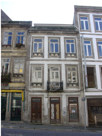
Fotografia 1 – Vista do alçado principal
