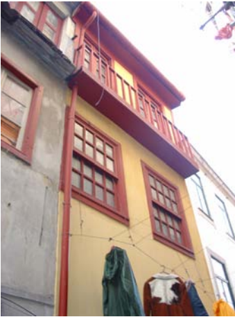
Fotografia 1 – Vista parcial do alçado principal
