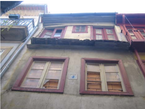
Fotografia 1 – Vista parcial do alçado principal
