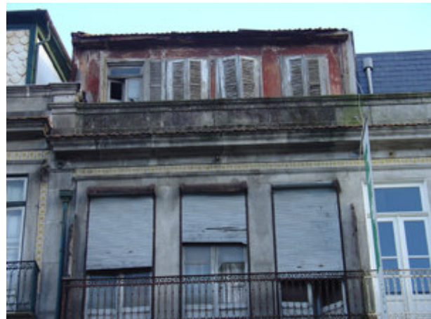
Fotografia 2 – Vista parcial do alçado principal
