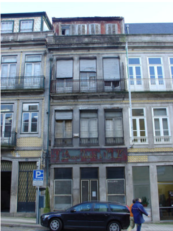
Fotografia 1 – Vista do alçado principal
