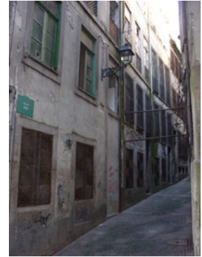
Fotografia 3 - Vista parcial do alçado tardoz (parcelas 1, 2 e 3)
