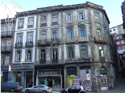
Fotografia 1 - Vista do alçado principal (parcelas 1, 2 e 3)
