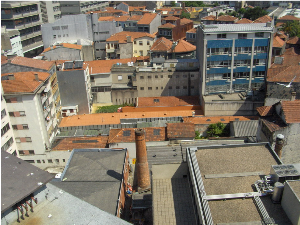
Vista sobre o caótico interior do quarteirão. À direita, em cima, o edifício do antigo Banco do Brasil
