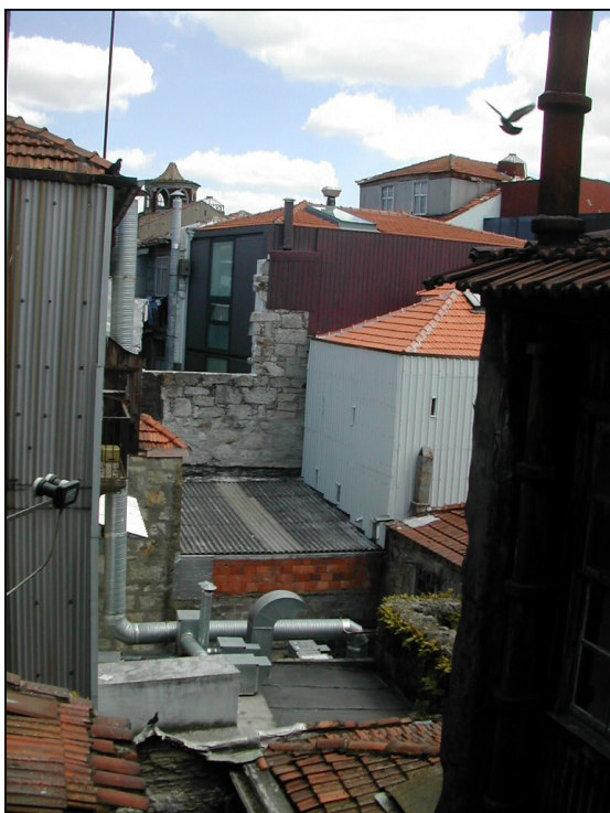
Vistas interiores dos logradouros na área central do quarteirão
